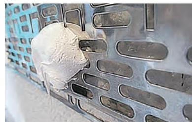
基盤のブリッジにしっかりと絡むように、接着剤を厚さ20mm以上のダンゴ状に塗布してください。基盤と接着剤を絡ませることが重要です。
