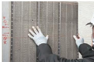
基盤のルーズホールに専用ビスまたはアンカーで固定します。
