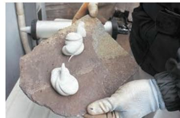
仕上材裏面に、接着剤を厚さ 20mm 以上のダンゴ状に塗布してください。接着剤の塗布面積は 30% 以上とし、偏らないようにしてください。
