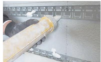
基盤のブリッジにしっかりと絡むように、接着剤を厚さ20mm以上のダンゴ状に塗布してください。基盤と接着剤を絡ませることが重要です。
