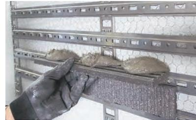
ベース金具の四角い穴または仕上材表面に、接着剤を厚さ20mm以上のダング状に塗布してください。ベース金具とキッコー網に基盤と接着剤を絡ませることが重要です。長方形タイルの縦張りやずらし張りにも対応できます。
