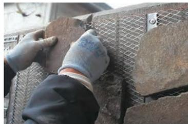
ドットピンのツメに仕上材を載せ、基盤と接着剤がしっかり絡むように揉み込んで張付けてください。
