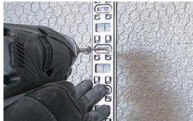
基盤のルーズホールに専用ビスまたはアンカーで固定します。
