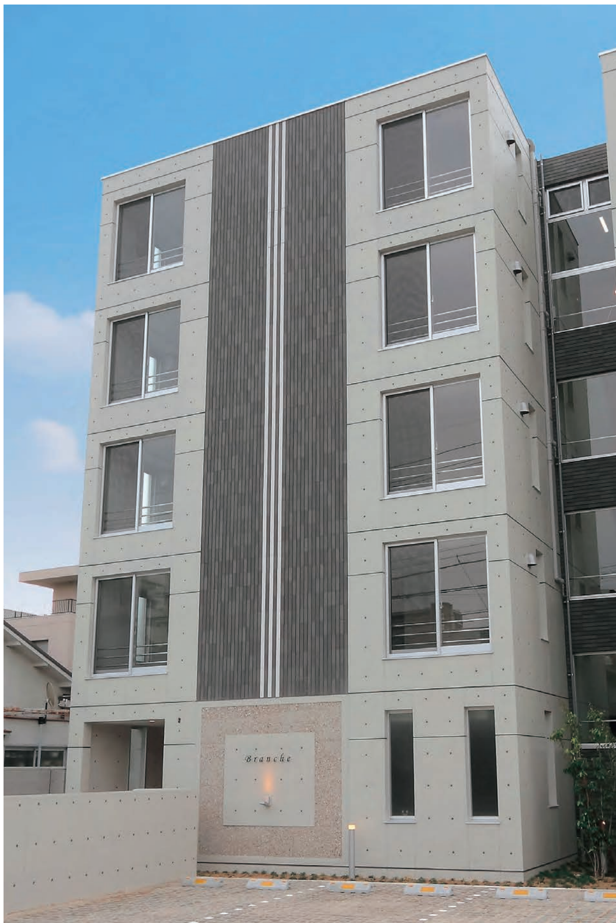
集合住宅 設計 ライフリビング株式会社 撮影 株式会社リフレクト 外壁アクセント:AUS-100 外壁一部:「デバイスII」KSN227R-110
