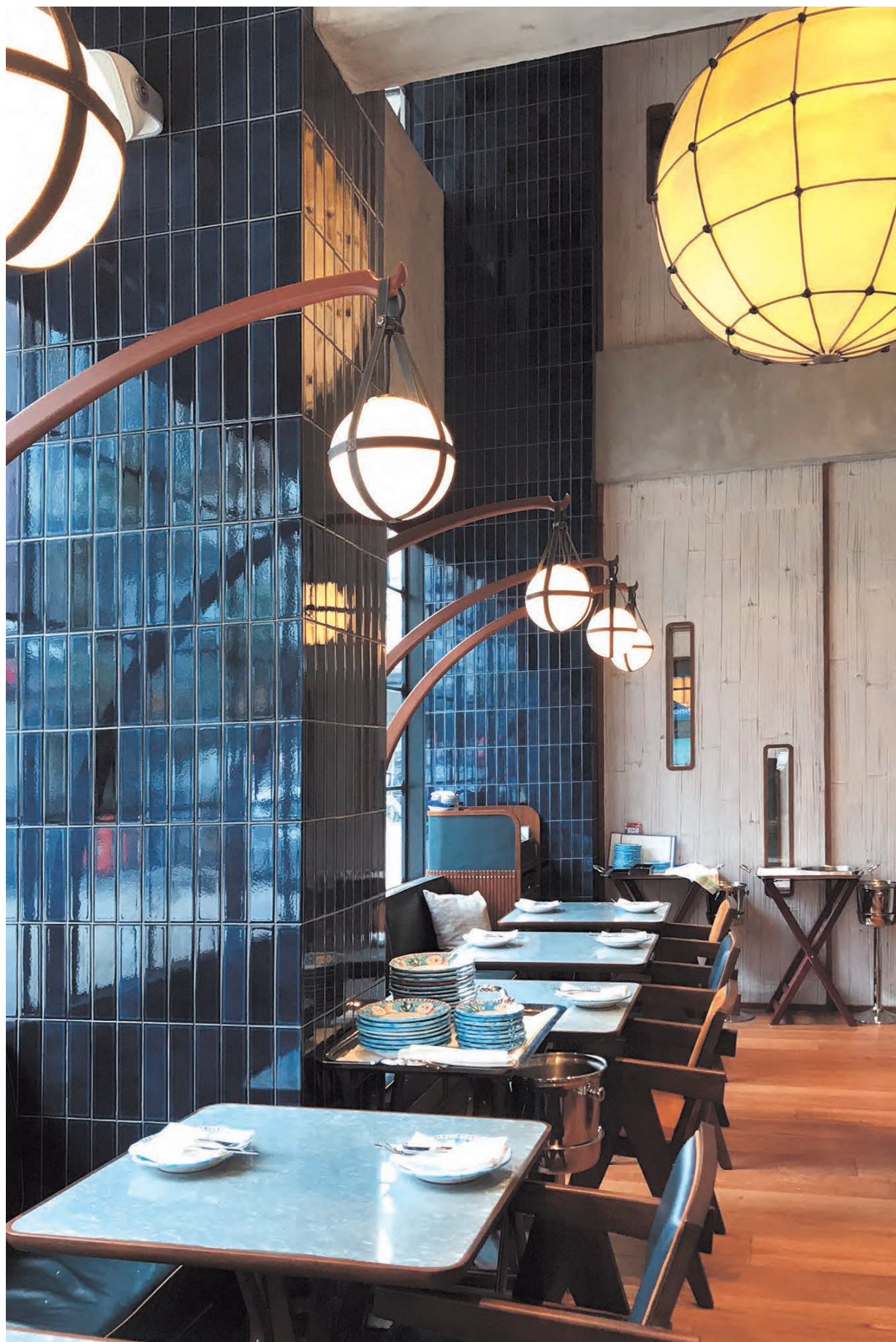
海外施工例 HSN-1204S (海外仕様の目地幅: 5mm)
